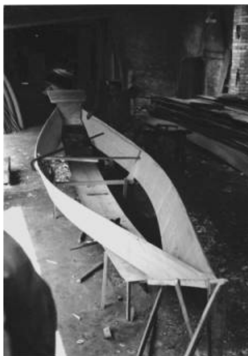
Fig. 1. Impostazione di un sàndolo nello squero Bovo di Burano, Venezia. Si noti come il primo corso di fasciame sia modellato solo fra asta specchio di poppa, ed un'unica ordinata centrale.
