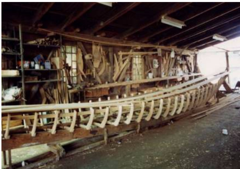
Fig. 6. Gondola impostata con il metodo "moderno," si noti il triplice supporto del fondo, lo scheletro completato e i due sérci appoggiati sopra pronti per essere fissati sui fianchi. Cantiere dei Rossi, Giudecca, Venezia.
